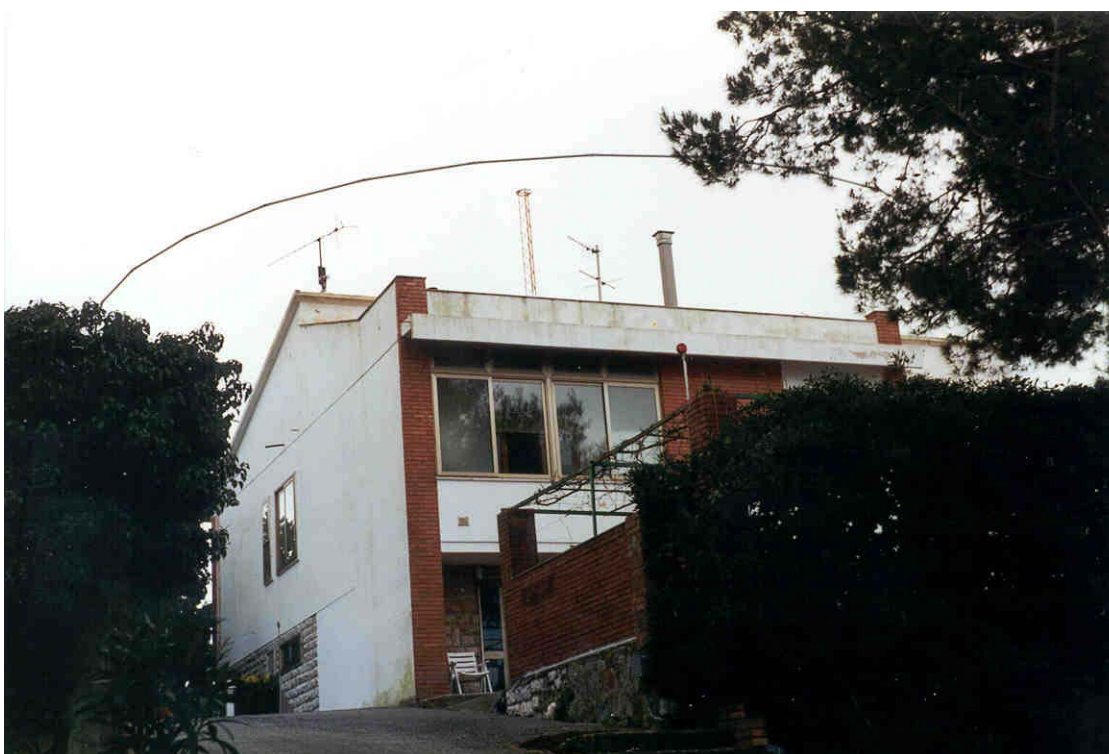
Vista ovest dell'edificio
