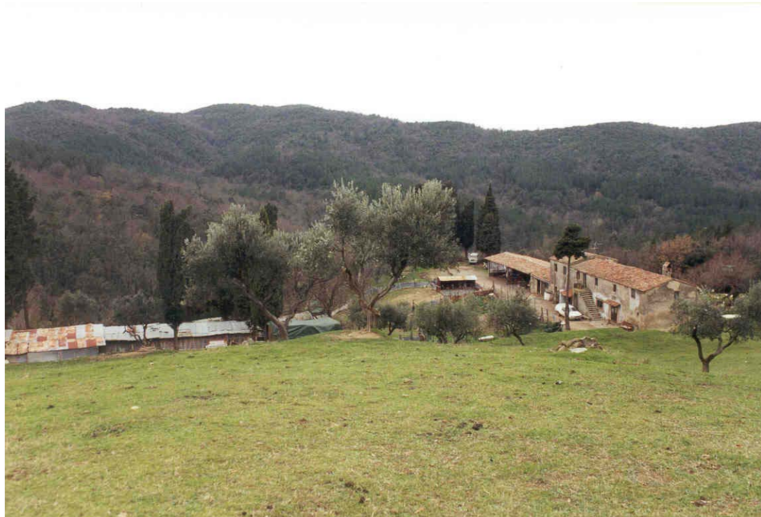
Vista ovest dell'edificio
