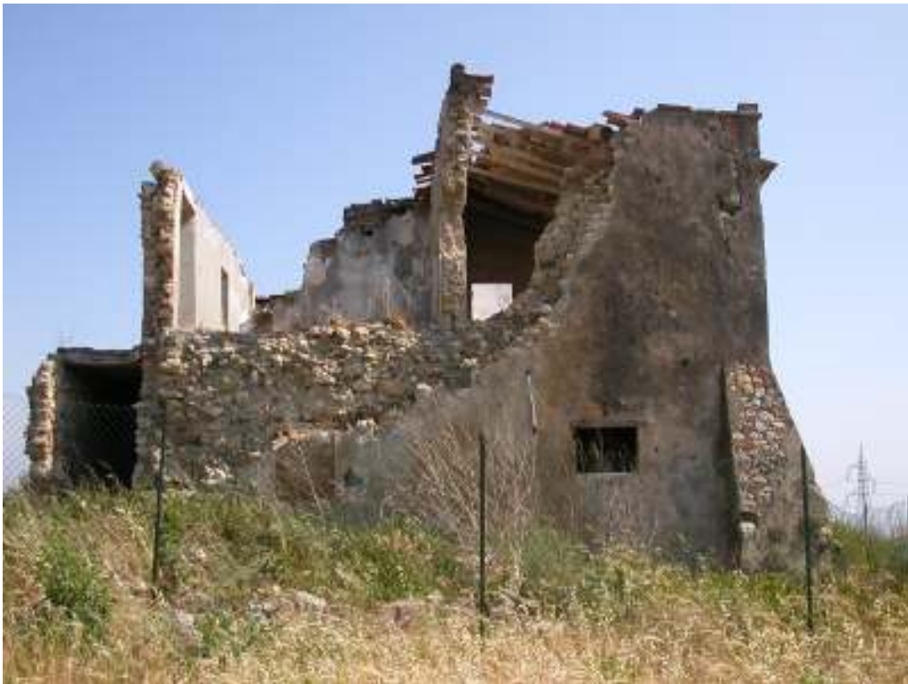
Viste dell'edificio prima del restauro
