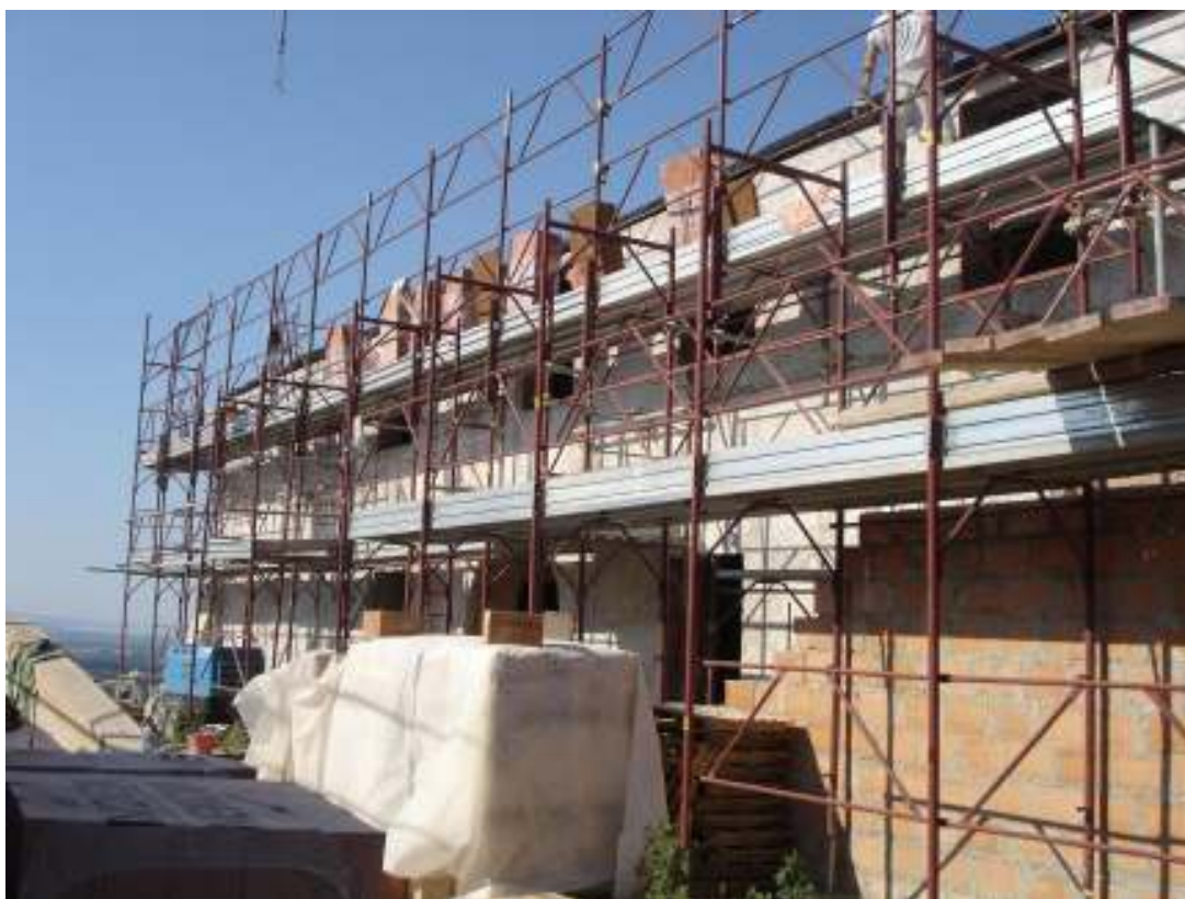
Vista dell'edificio in fase di restauro
