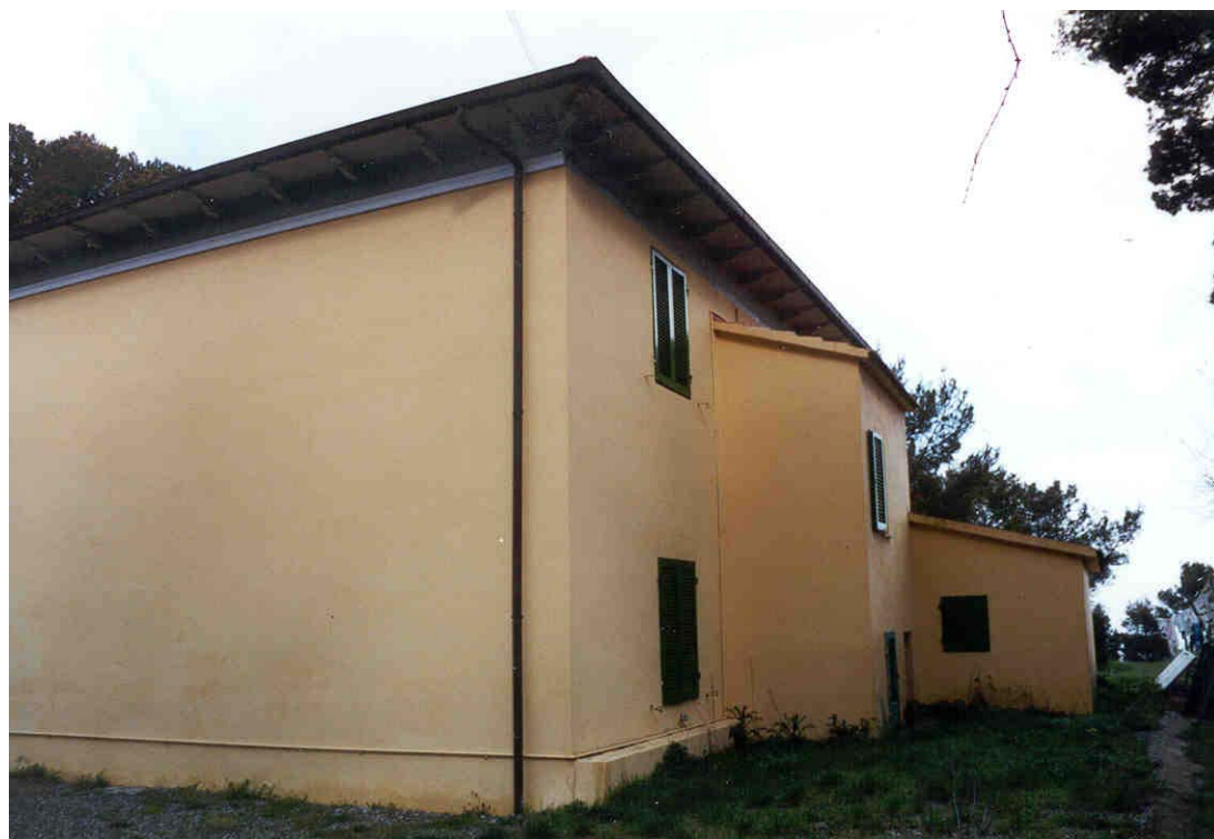
Vista ovest dell'edificio
