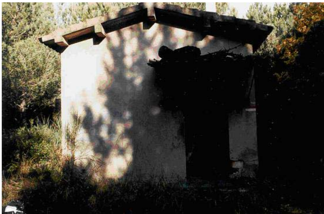
Fronte principale dell'edificio
