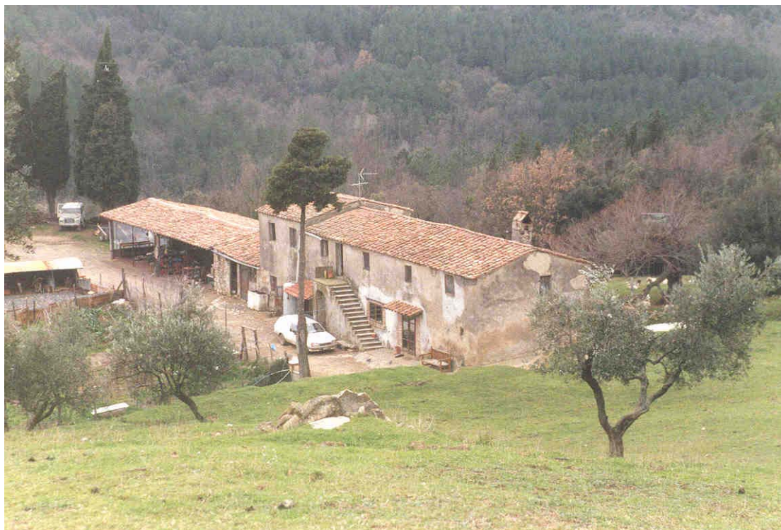
Vista nord-est dell'edificio
