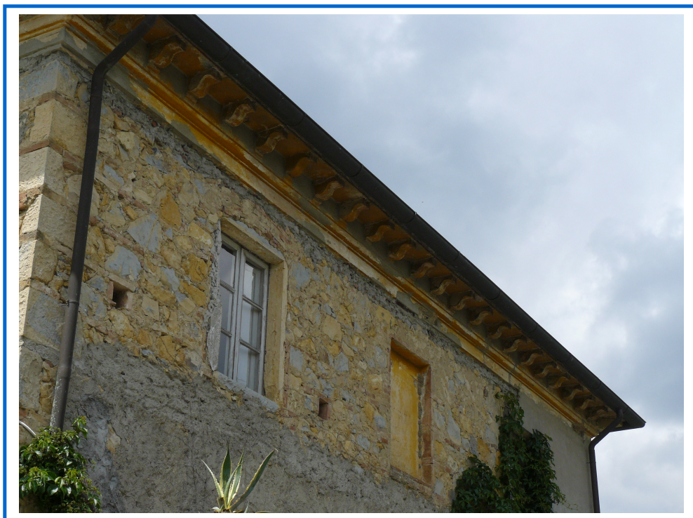
Il fabbricato "A", particolare della muratura e del sottogronda
