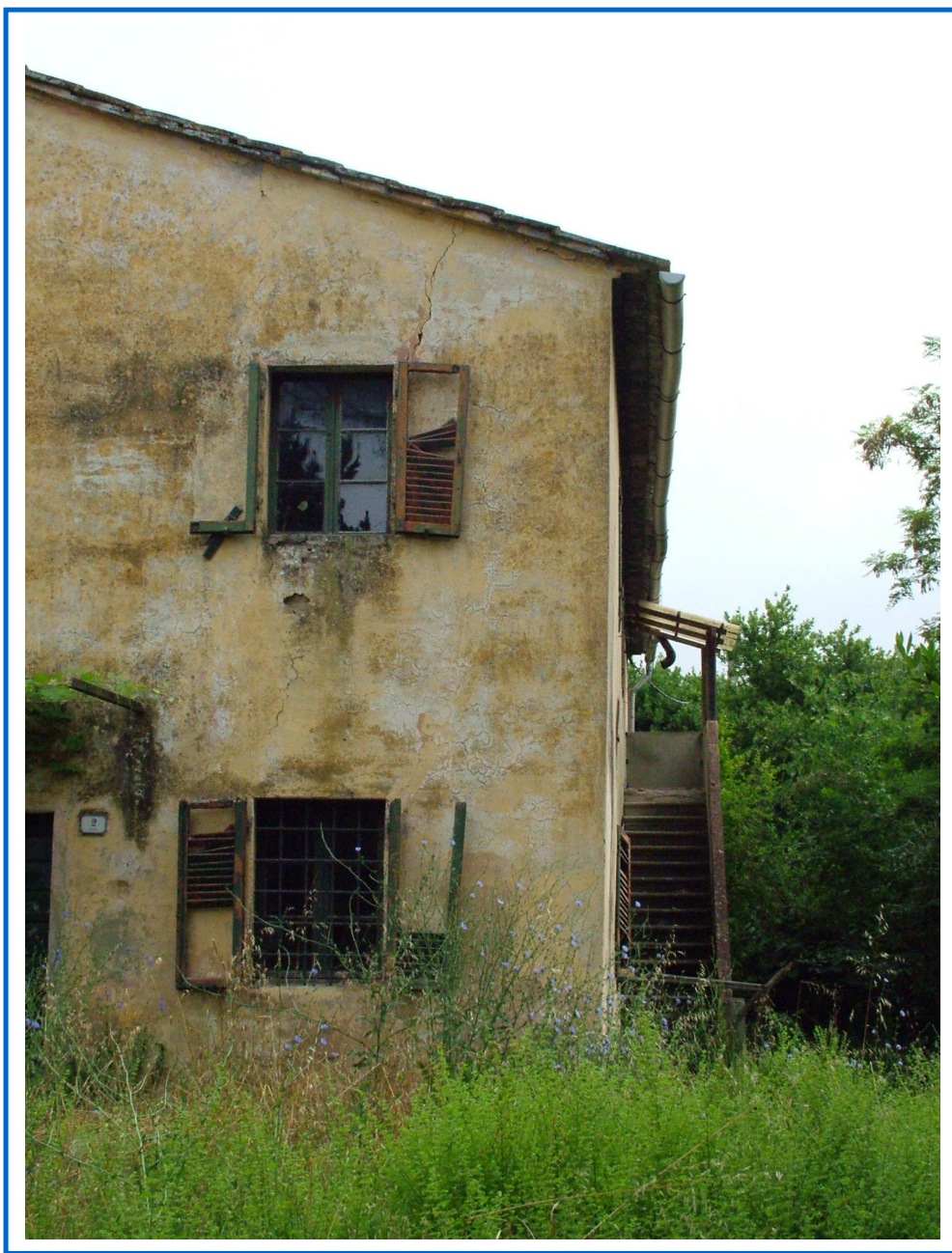
Dettaglio della scala esterna e degrado degli infissi
